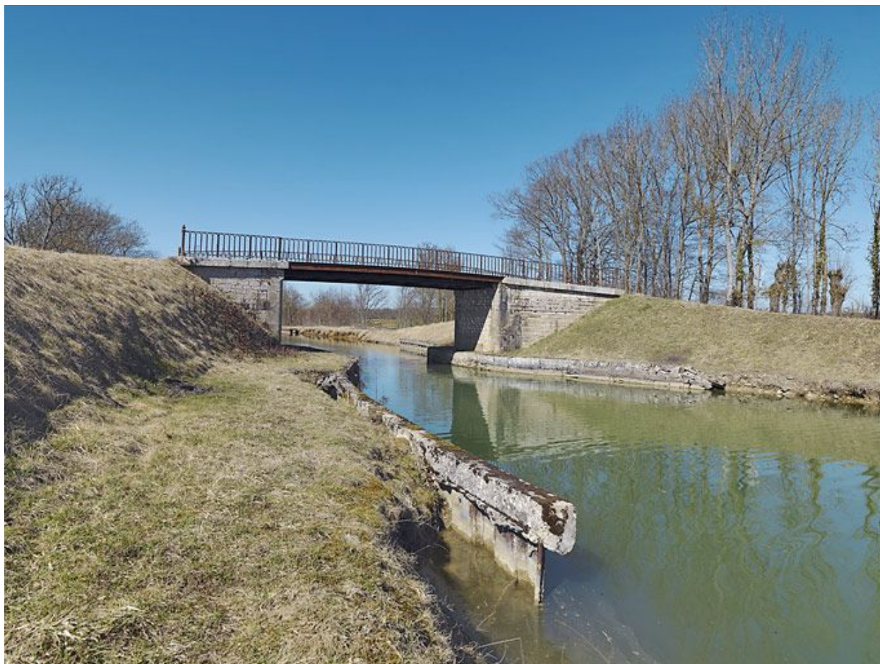
Vue d'ensemble du pont.
