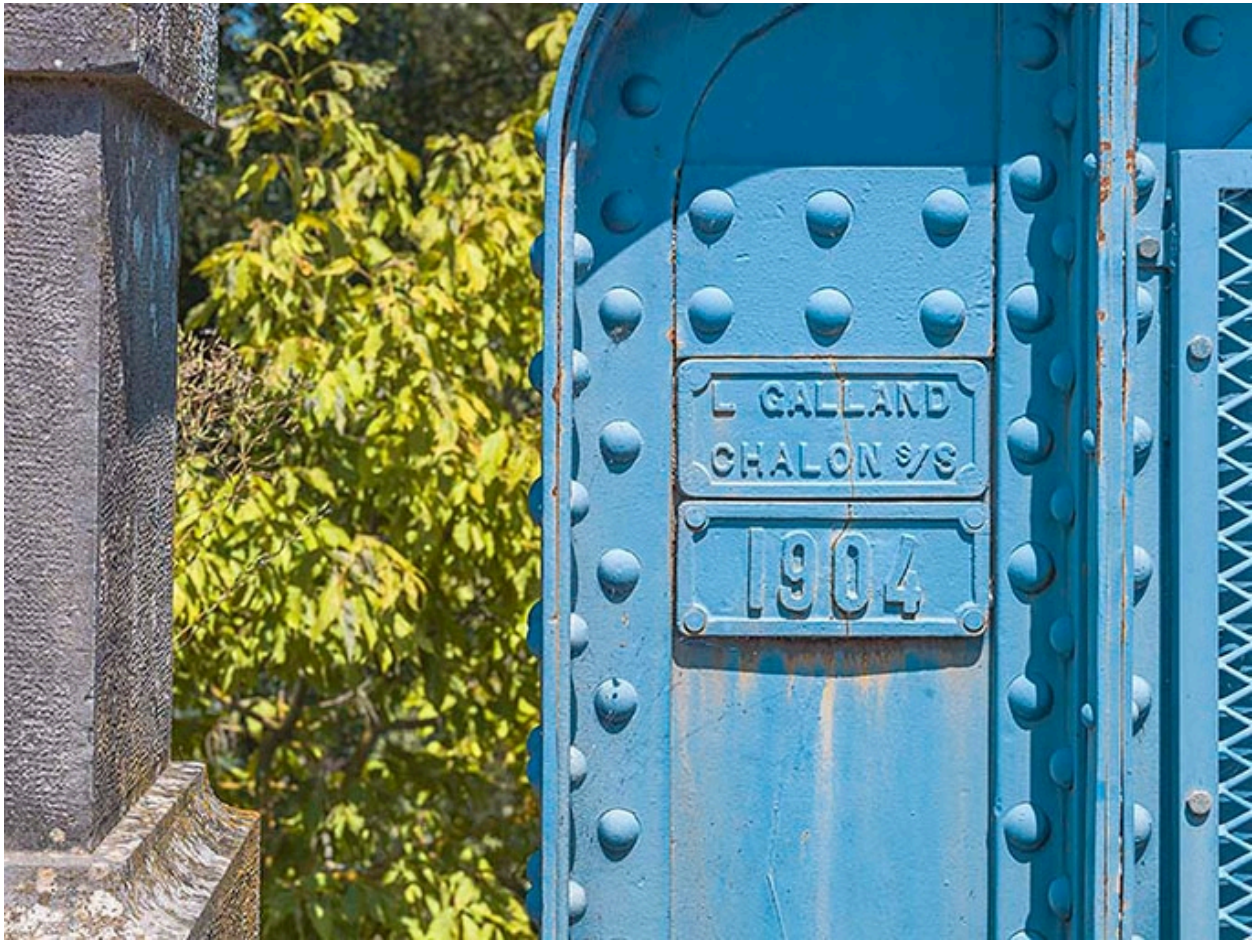
Détail du garde-corps du pont avec le nom de l'entrepreneur et la date.
