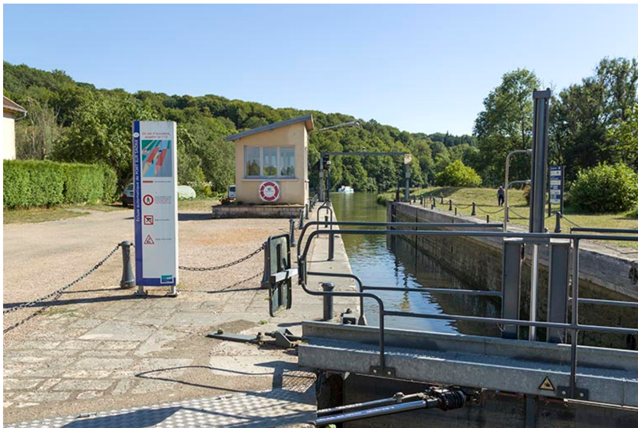
L'écluse et le poste de commande.
