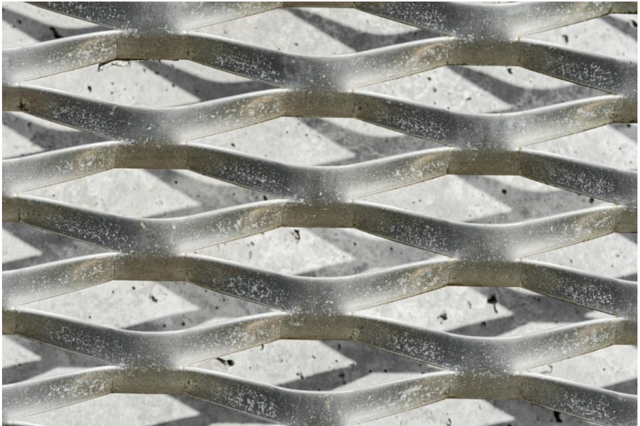
Résille métallique : détail.
