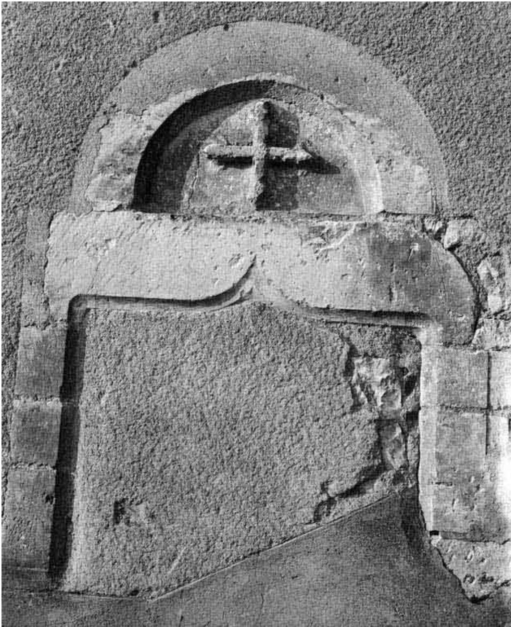
Porte murée, façade droite.
