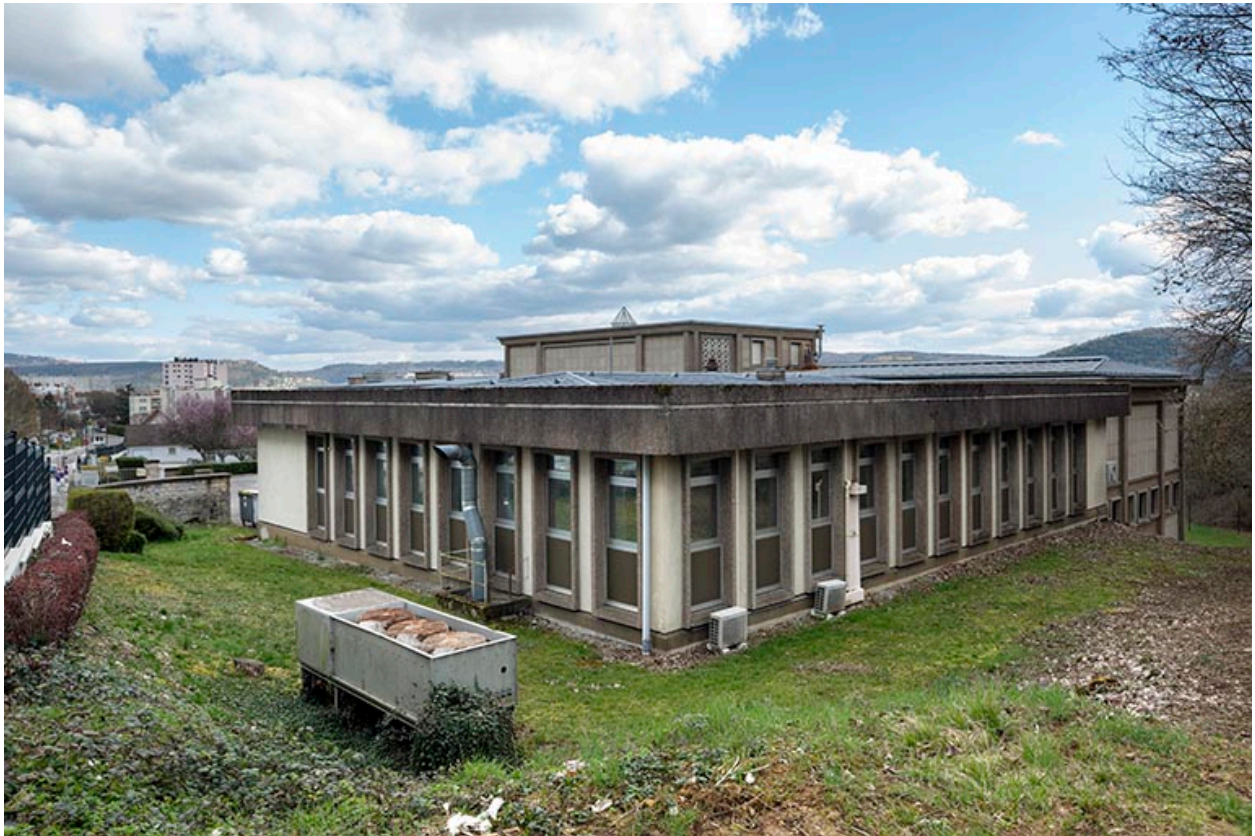
Ancien laboratoire de métrologie, depuis le nord-ouest.
