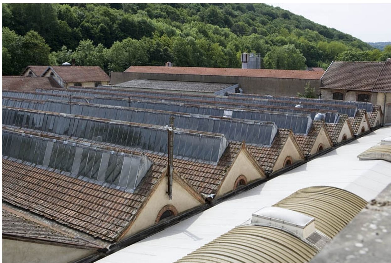
Atelier de fabrication. Vue des toitures.
