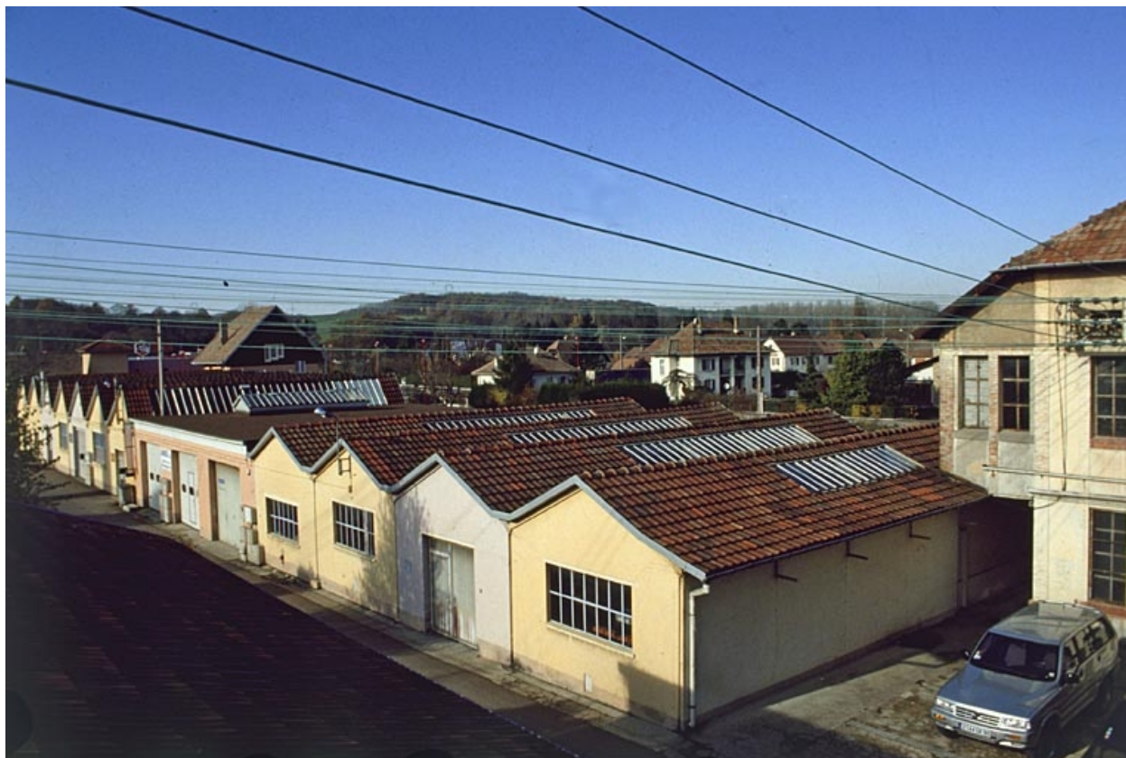
Ateliers et remises au nord.
