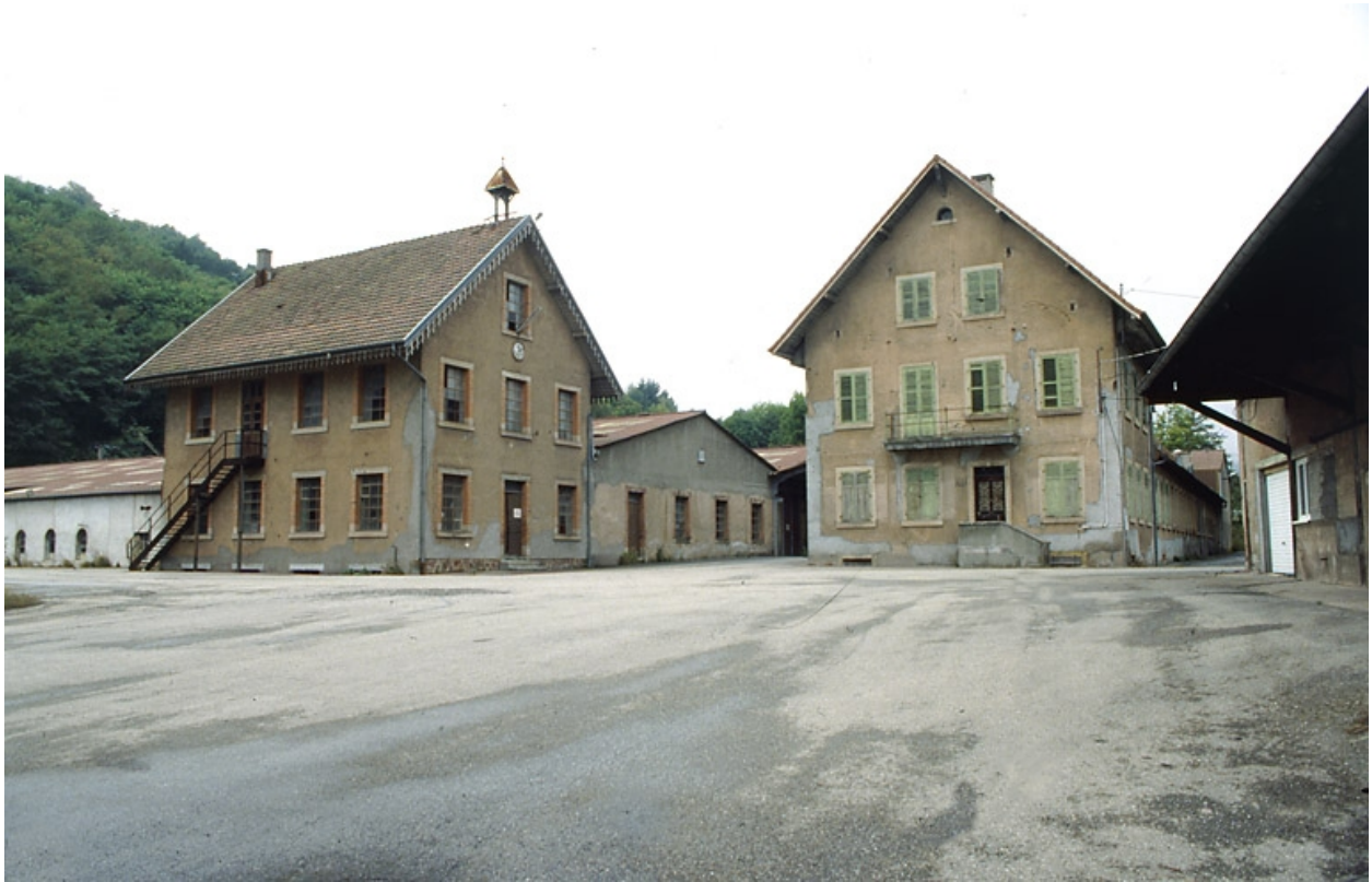
Laboratoire, bureaux et conciergerie depuis le sud.
