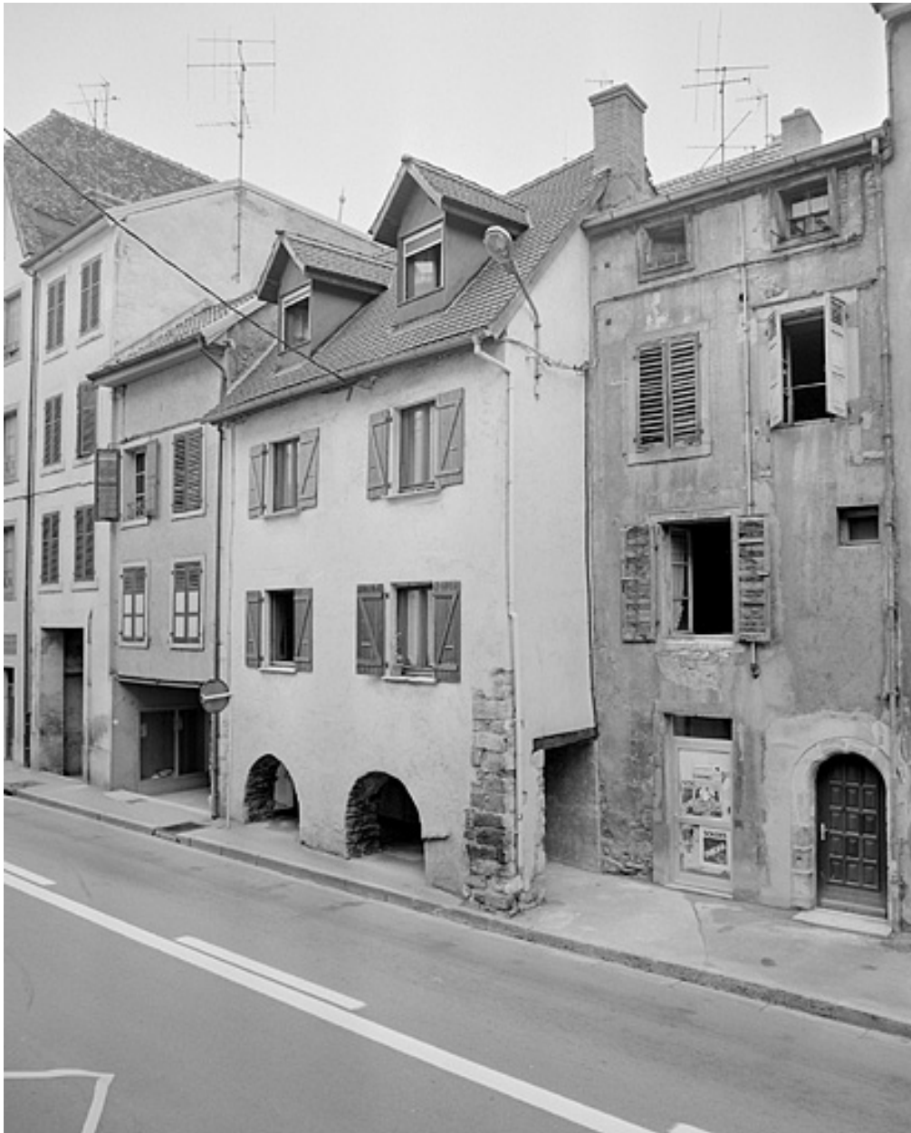
Maison 18, rue Cuvier. Façade sur la rue de la Schliffe. 16e siècle ?
