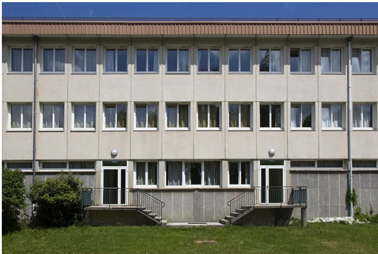
Ancien externat 1er cycle : façade latérale gauche.
