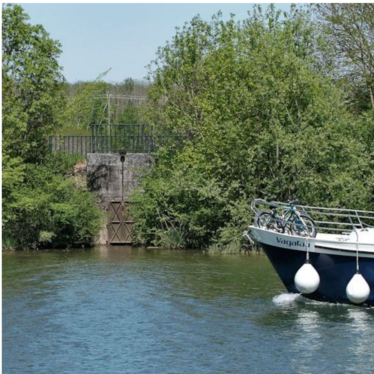
Vanne de l'aqueduc, Seille au premier plan.
