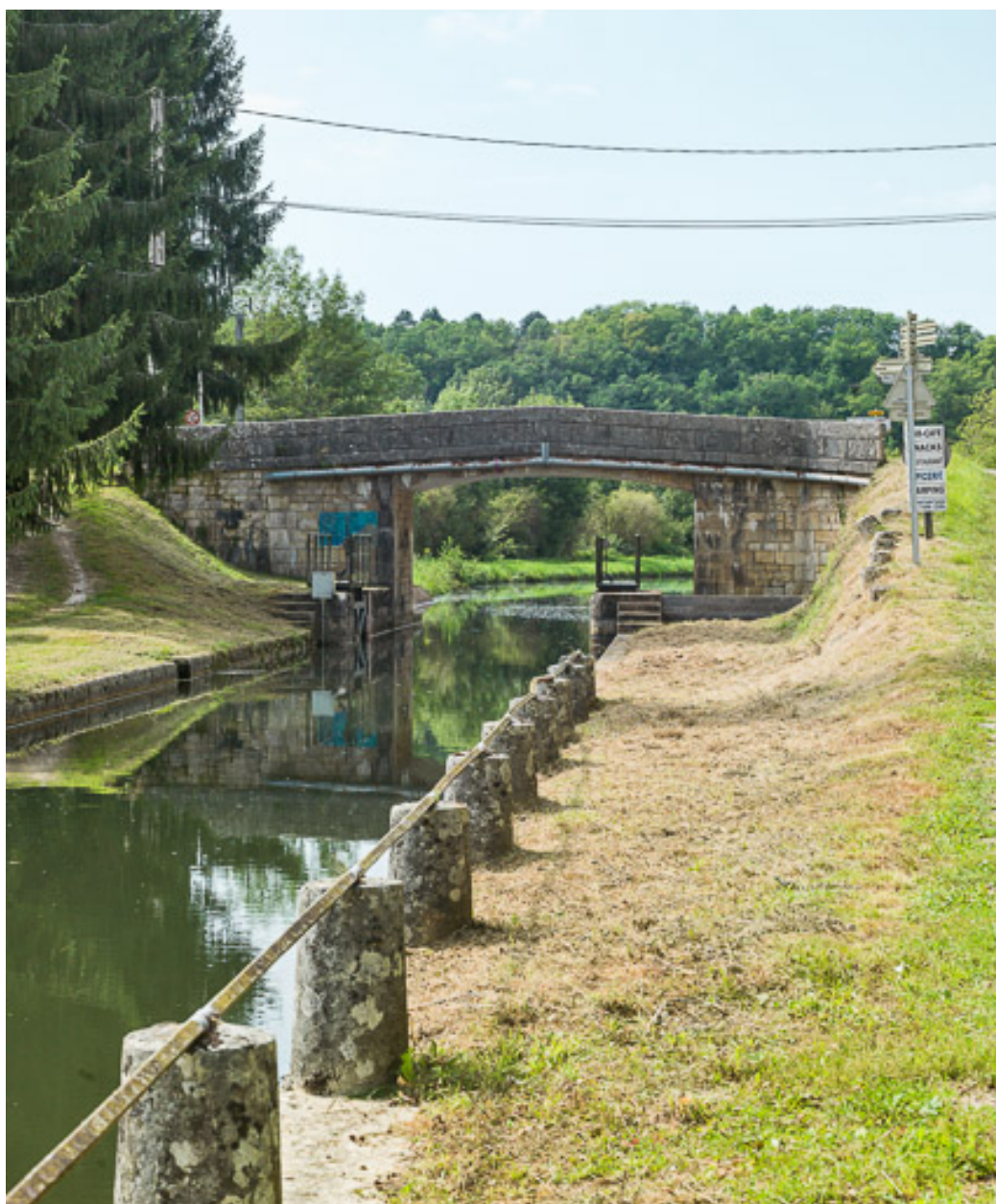
Vue du pont.
