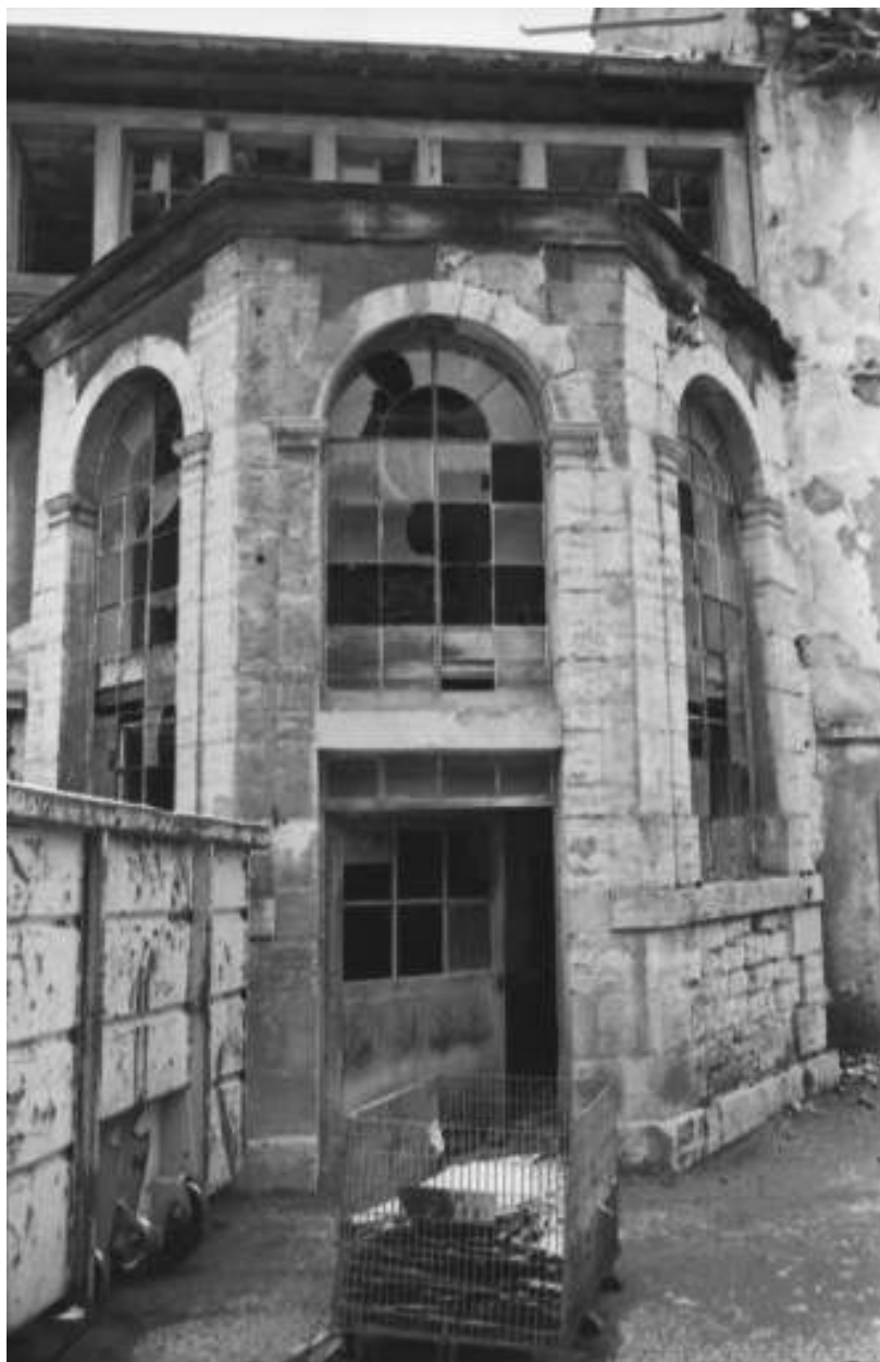
Atelier d'horlogerie. Détail de l'entrée en 1979.
