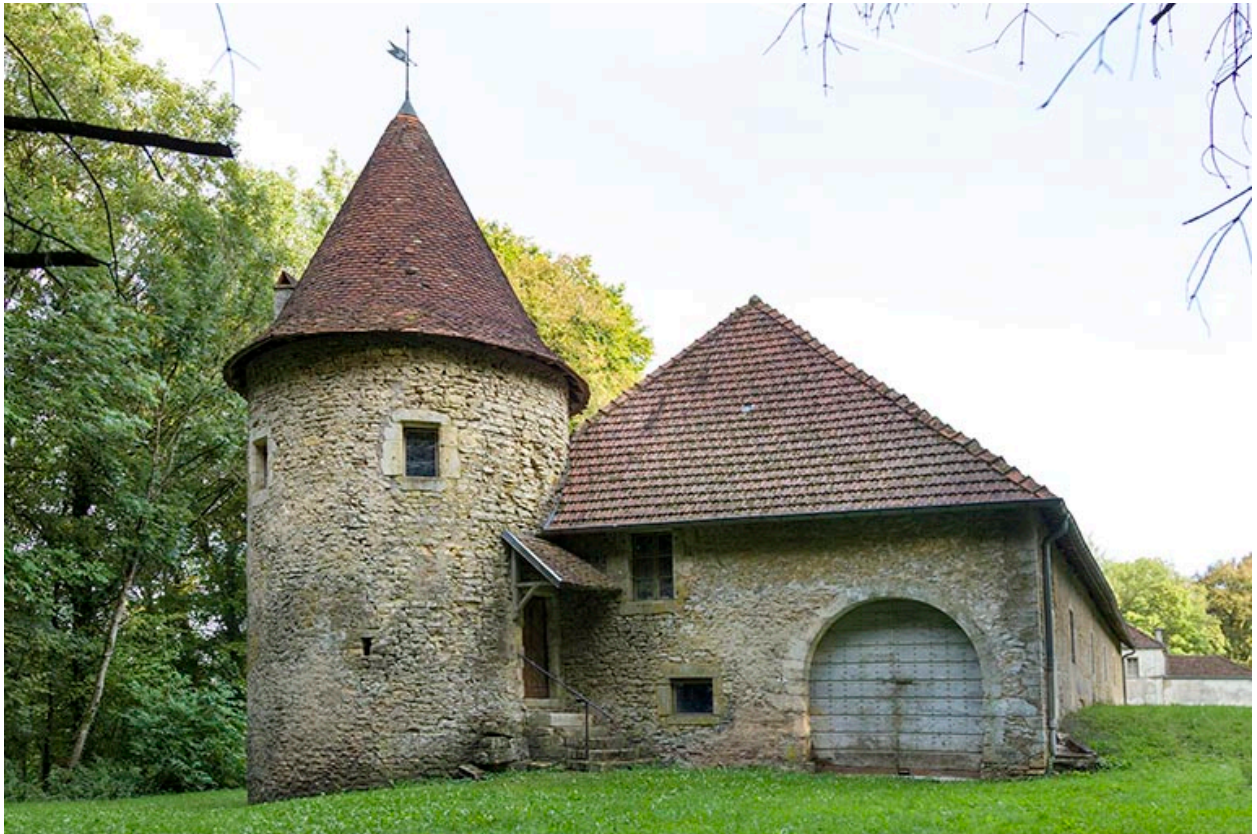
L'entrée du cuvage et la tourelle située au nord-est.
