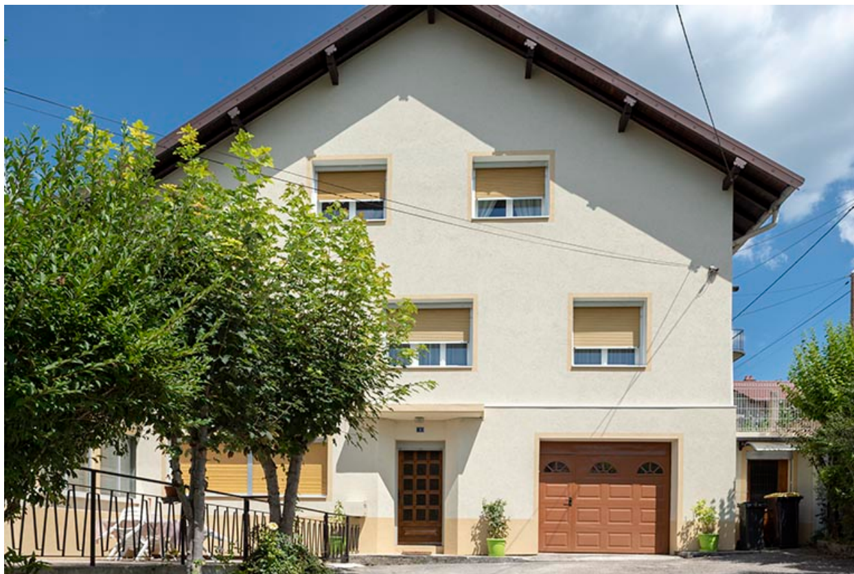
Maison : façade antérieure.
