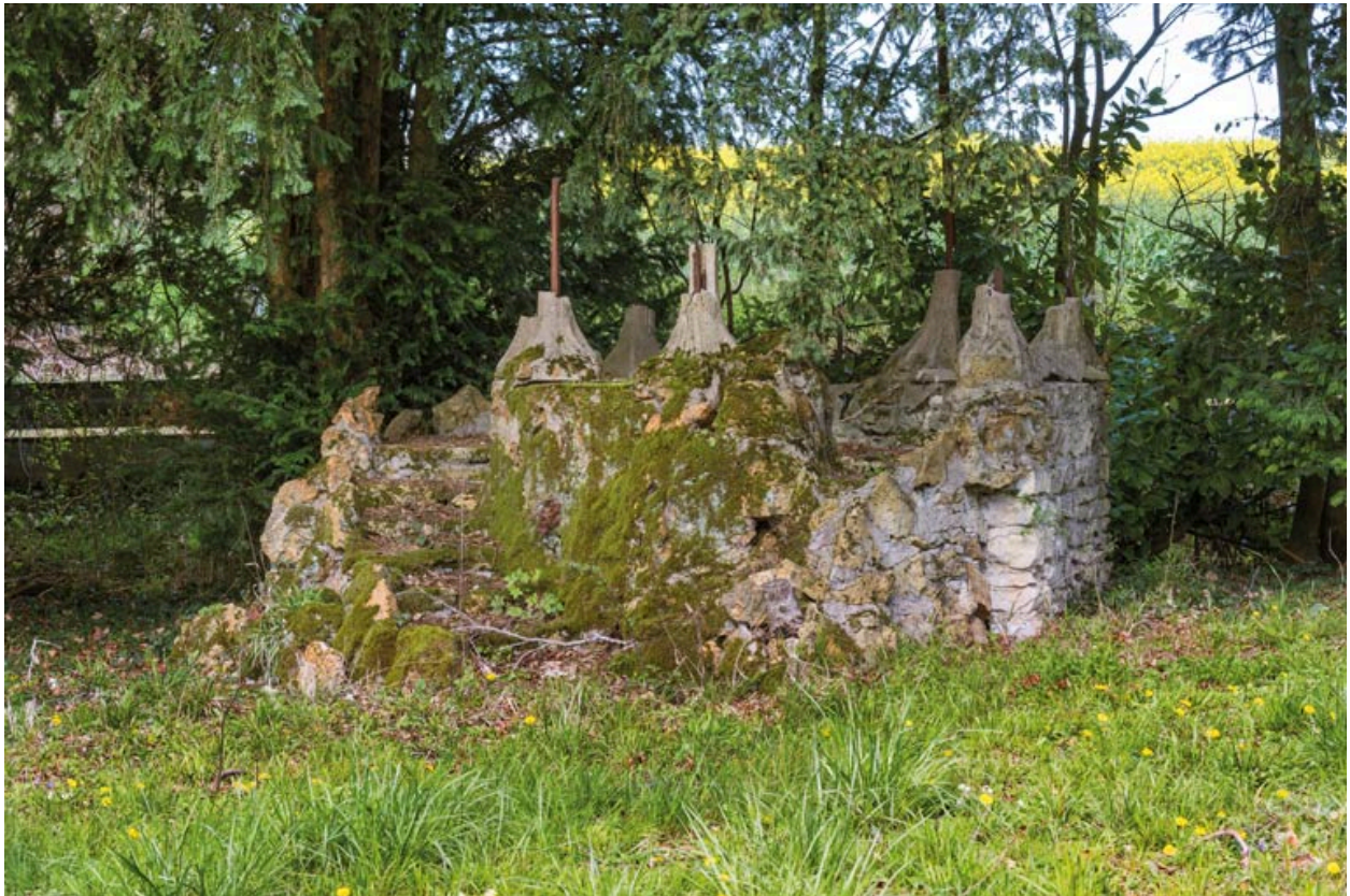
Kiosque rustique (vestiges).
