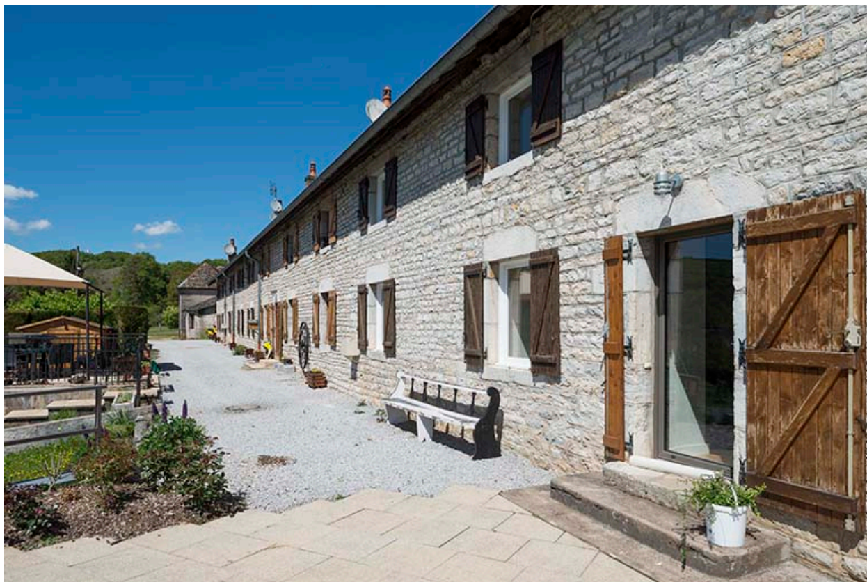
Logement ouvrier. Façade antérieure de l'aile sud.
