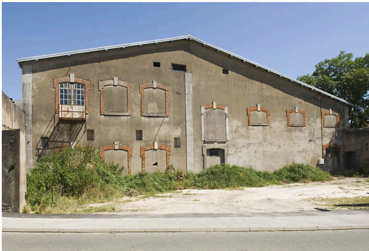
Façade sud d'ateliers de la papeterie.
