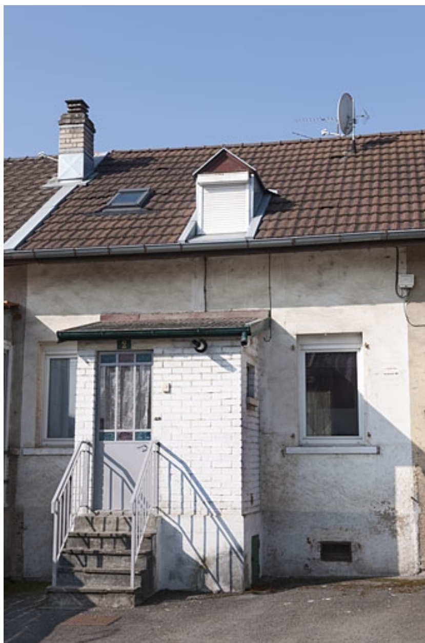
Détail d'une travée d'une habitation à 4 logements.
