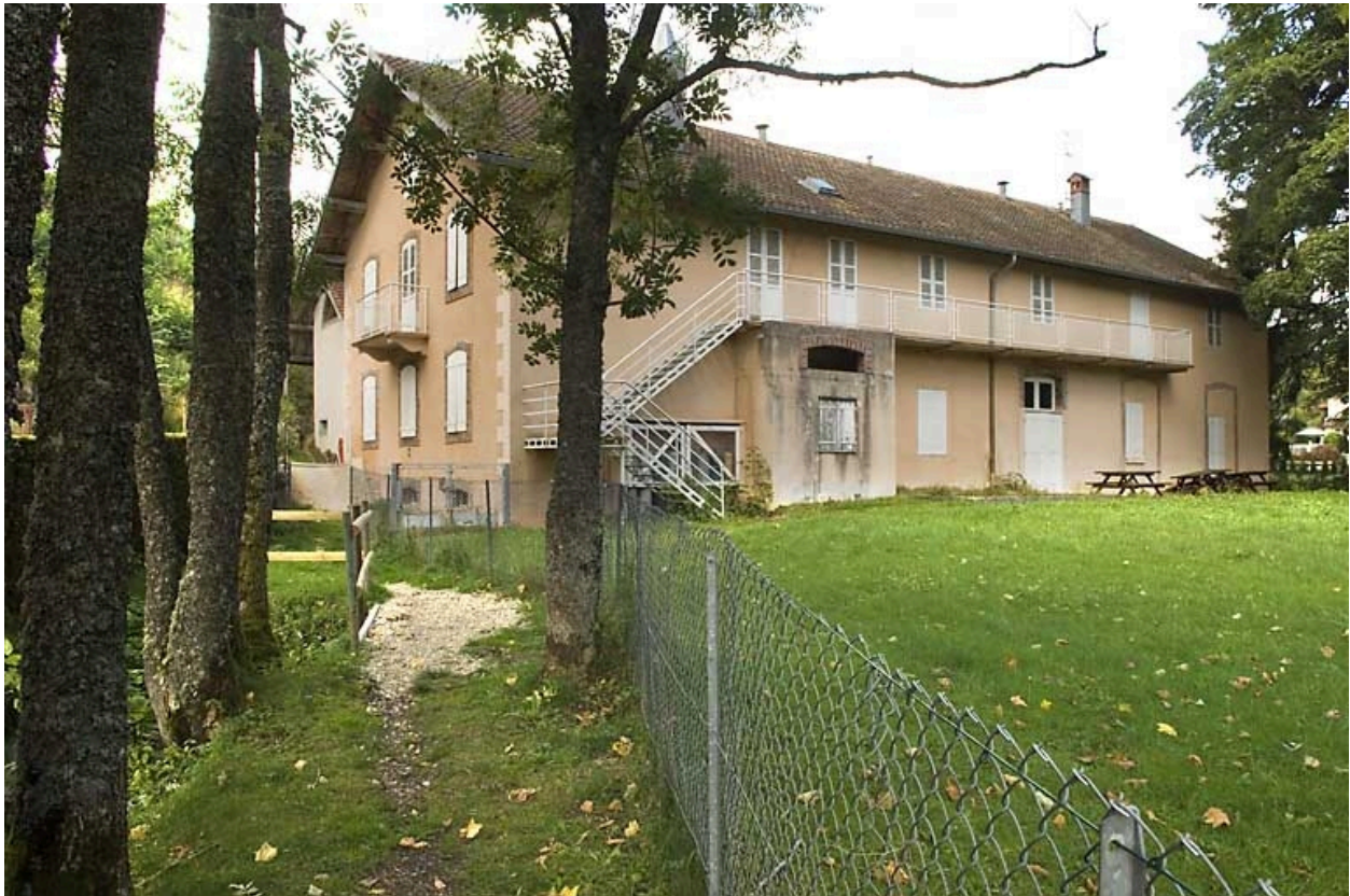
Bâtiment 25 rue des Forges : façade postérieure, de trois quarts gauche.
