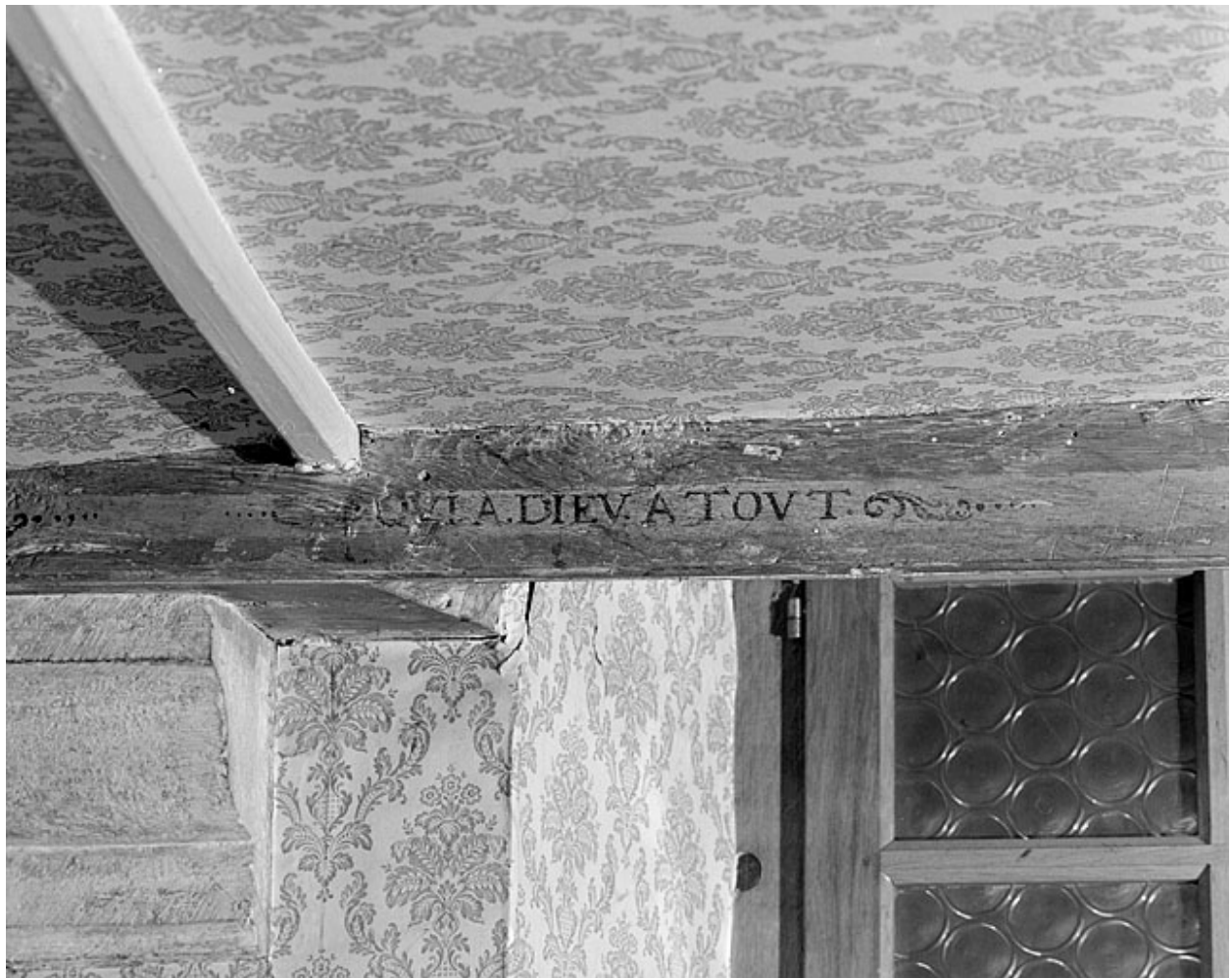
Premier corps de bâtiment. Plafond du rez-de-chaussée.
