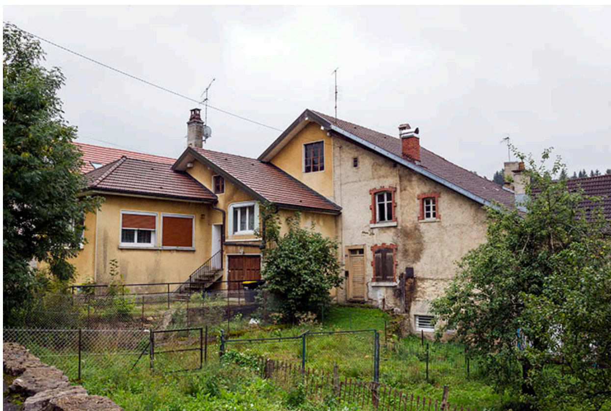
Vue d'ensemble, depuis le nord-ouest (façade postérieure).
