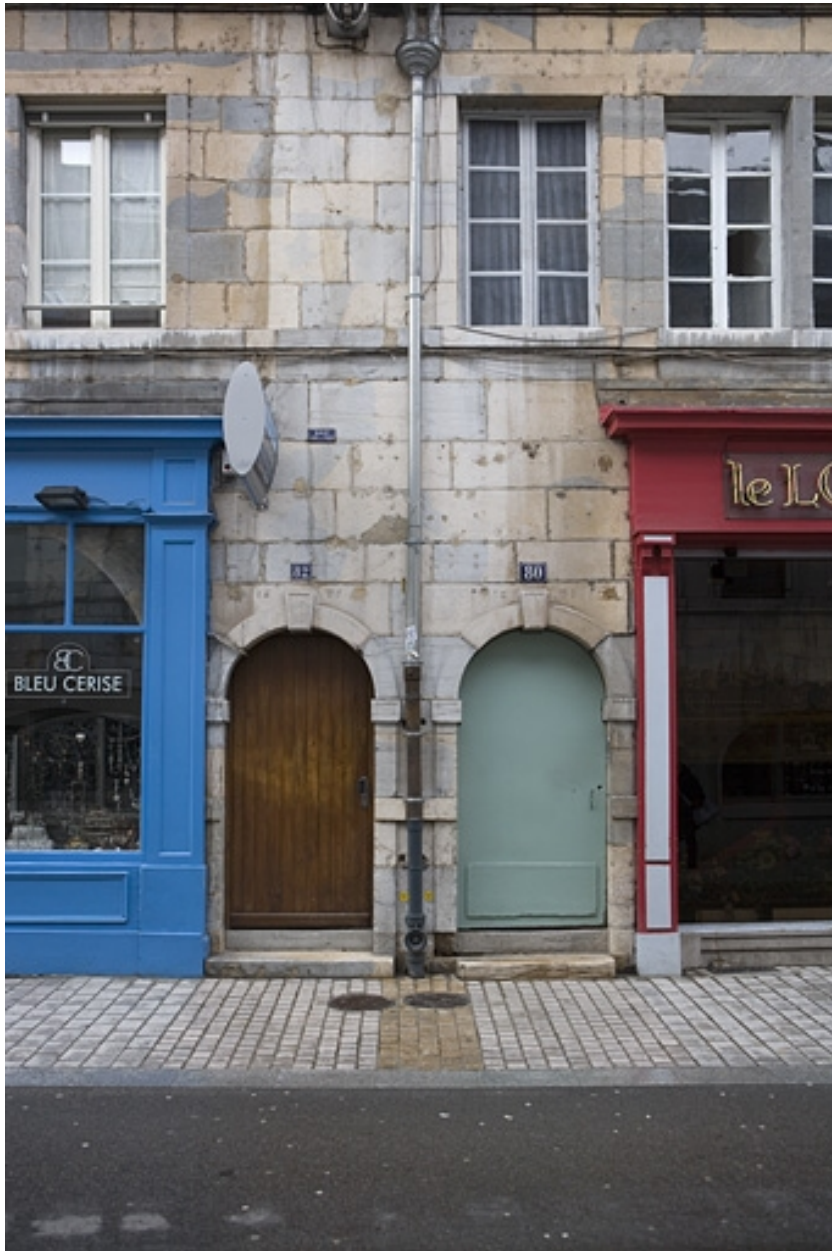
Façade sur rue : détail de la porte d'entrée du couloir.
