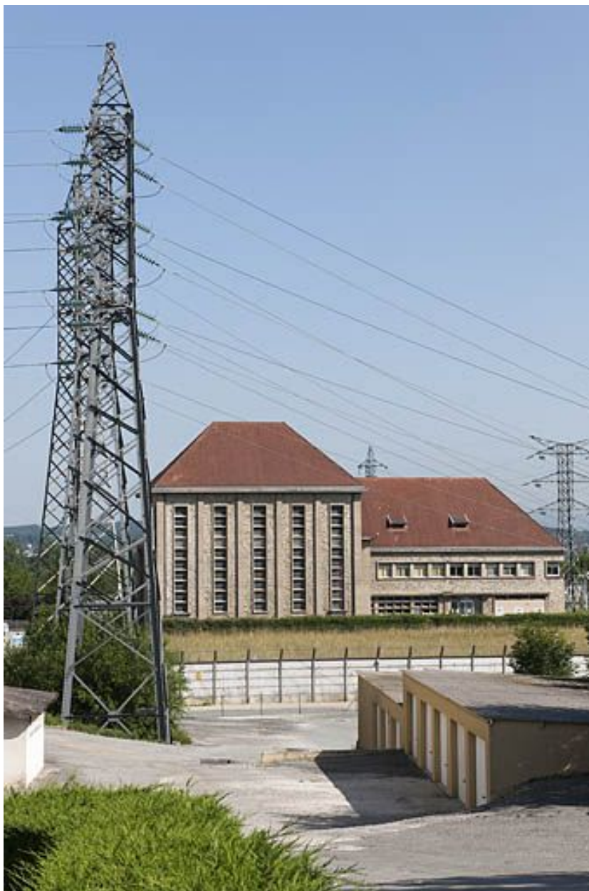
Nouveau poste de transformation.
