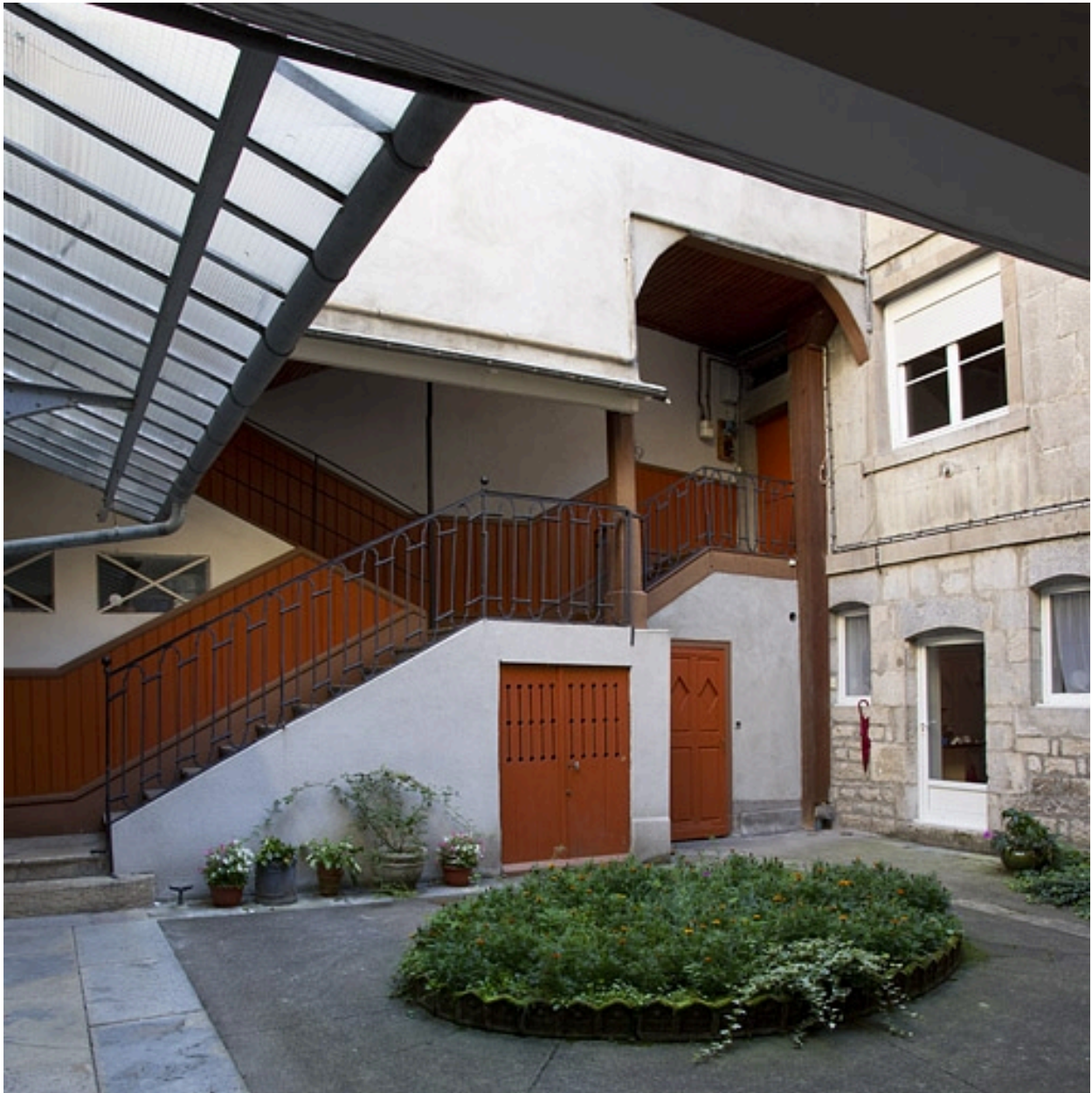
Vue d'ensemble de l'escalier à cage ouverte sur cour, de trois quarts gauche.
