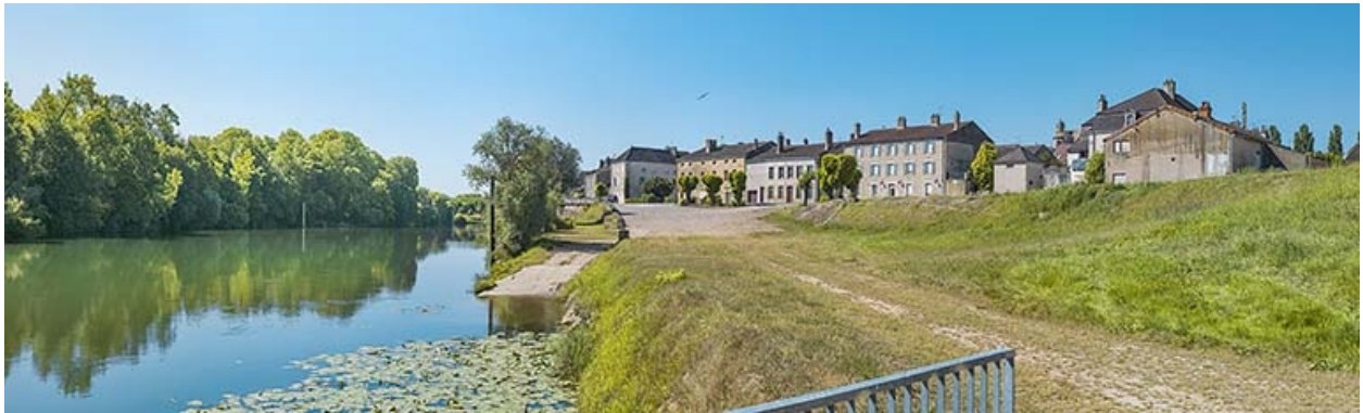
Quais et port, avec rampe d'accès, vus d'aval.
