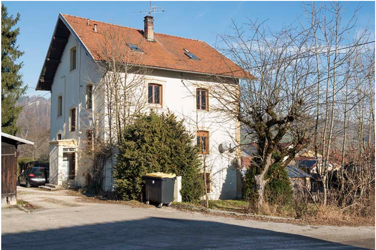
Façades postérieure et latérale gauche.
