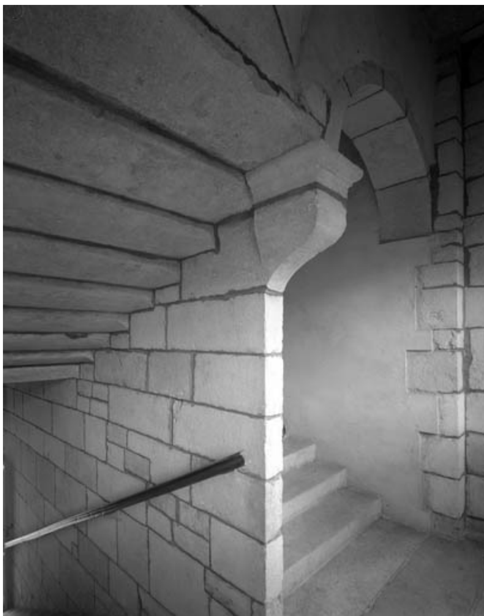
Détail de la montée d'escalier.
