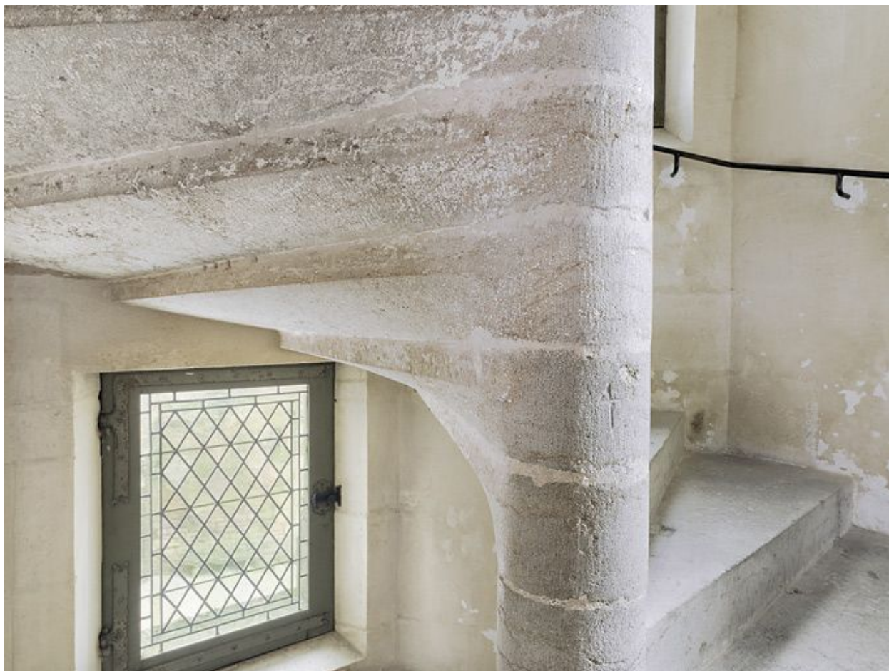
Détail de l'escalier en vis du grand logis.
