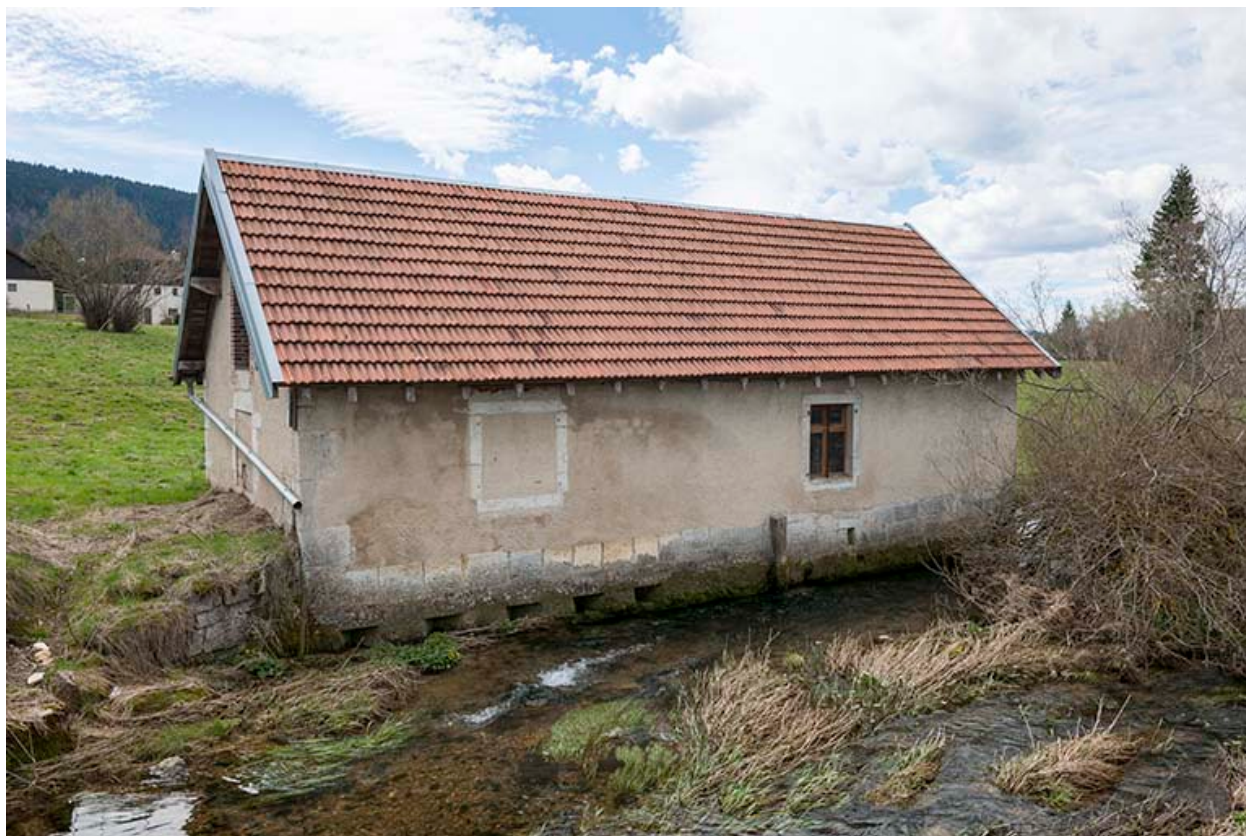
Ancienne forge. Façade nord.
