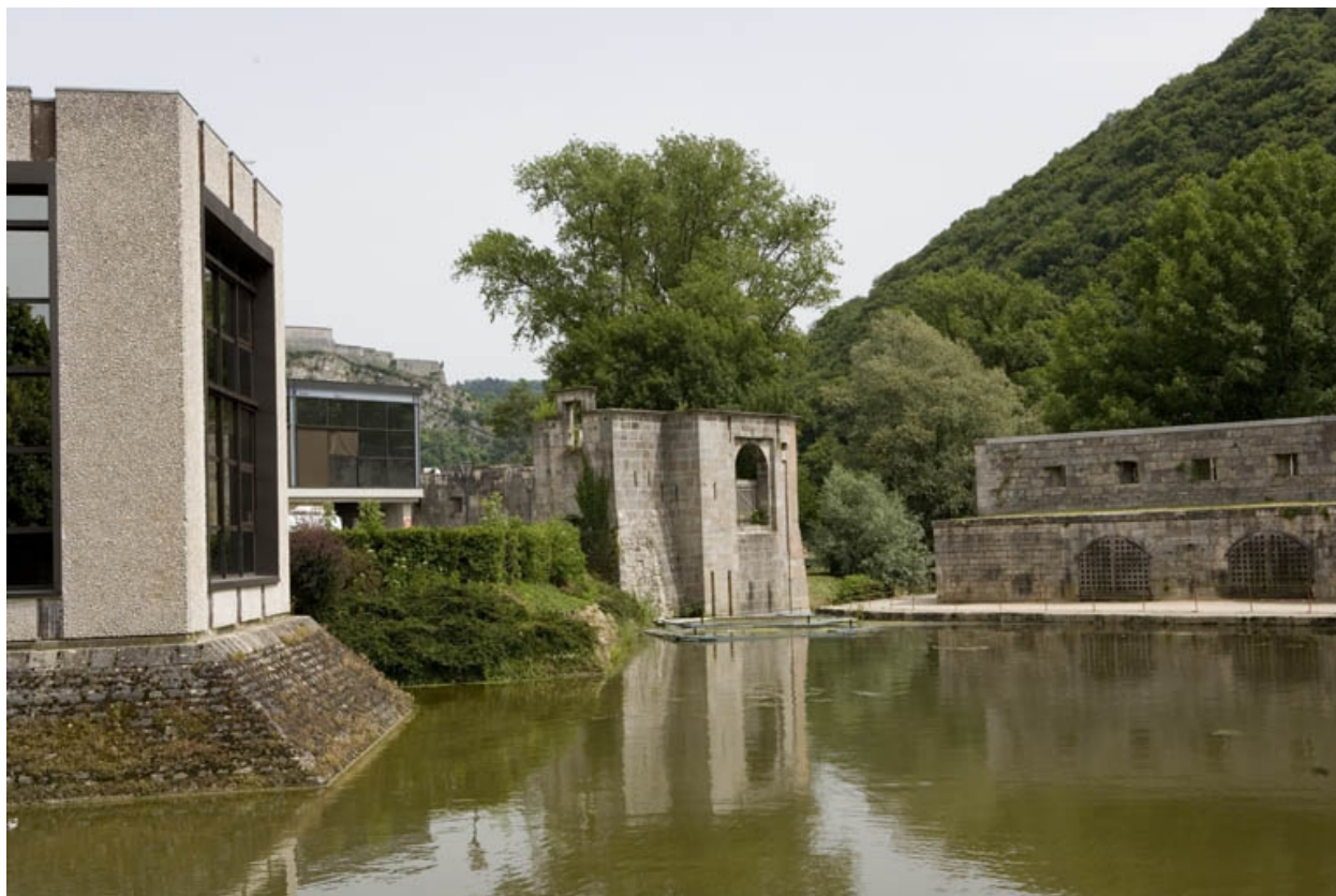
Bassin et chenal, interrompant la courtine.
