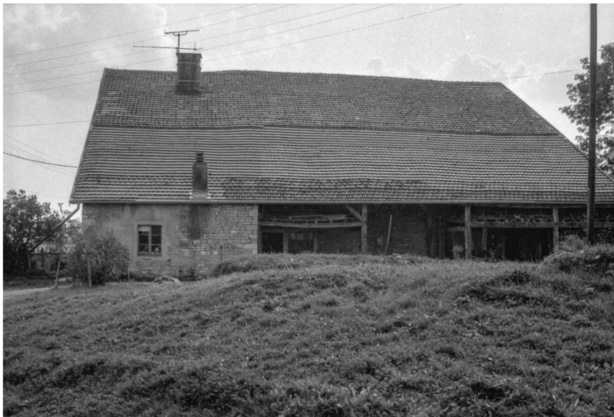
Façade latérale droite.
