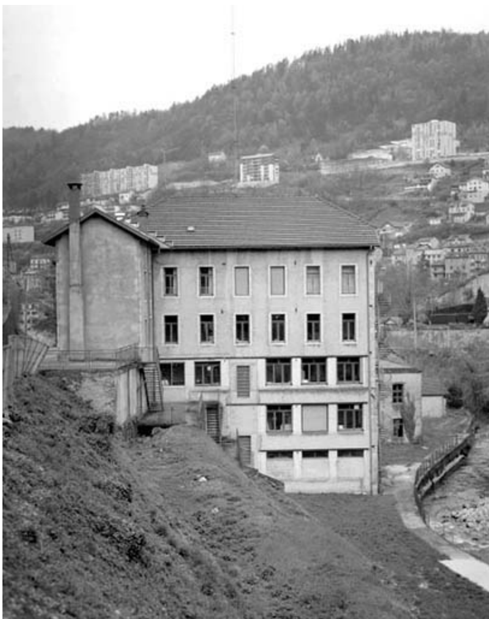
Ateliers de fabrication depuis l'est.
