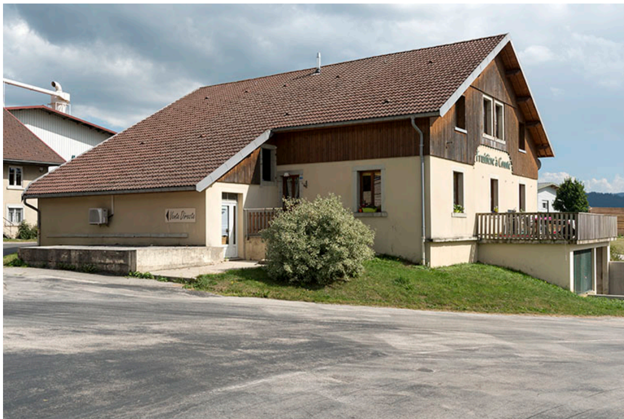
Façades postérieure et latérale droite.
