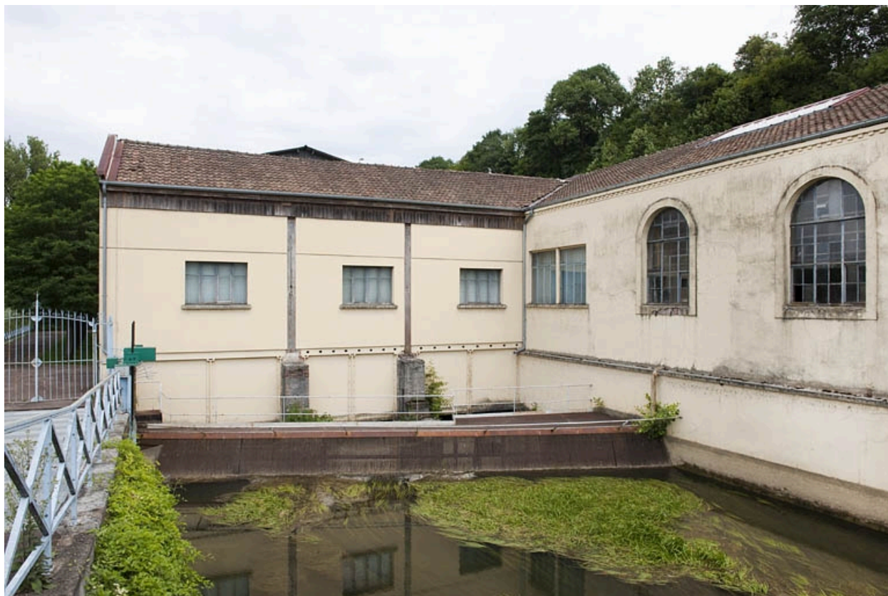
Bâtiment d'eau vu depuis l'amont.
