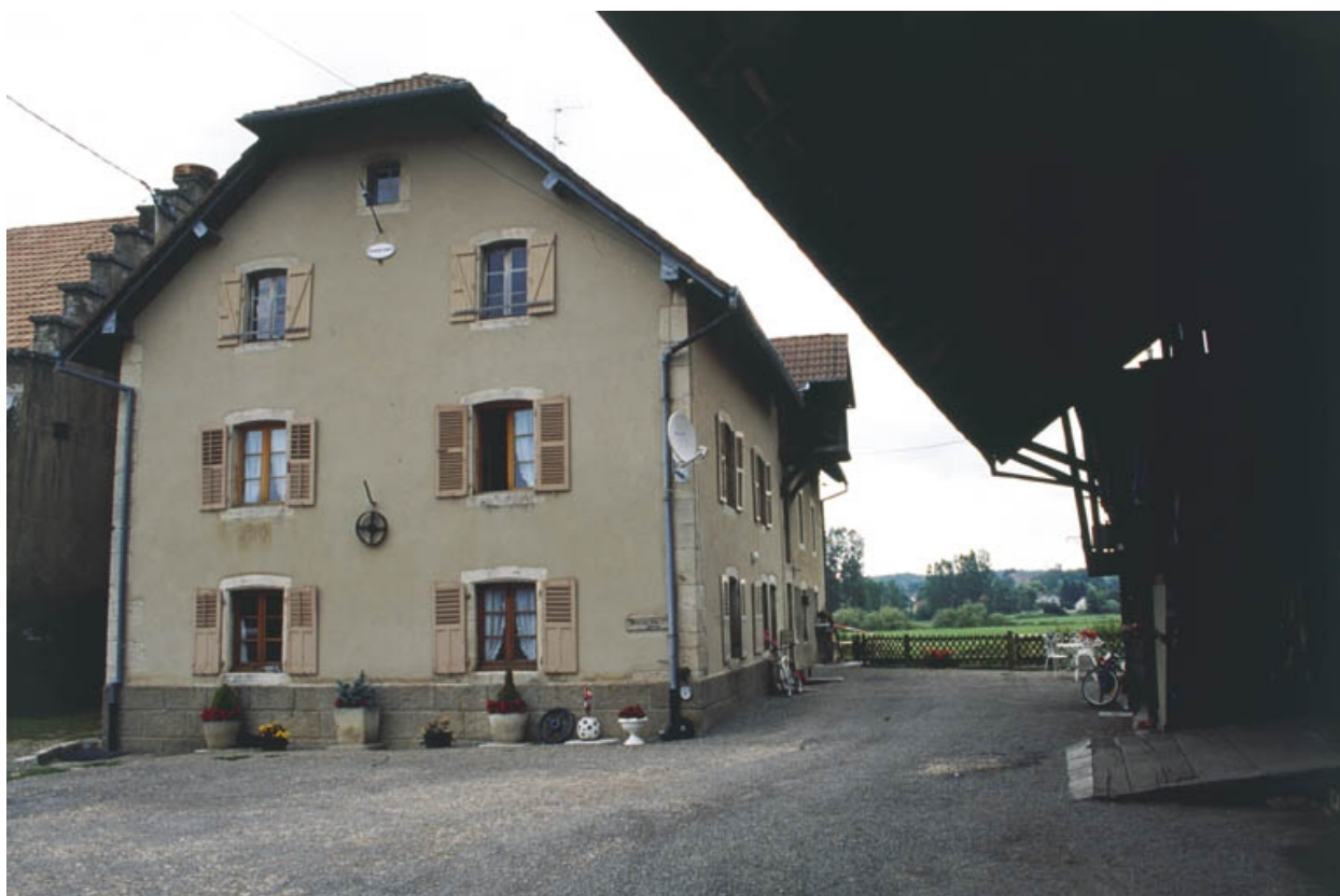
La minoterie et son logement depuis l'ouest.
