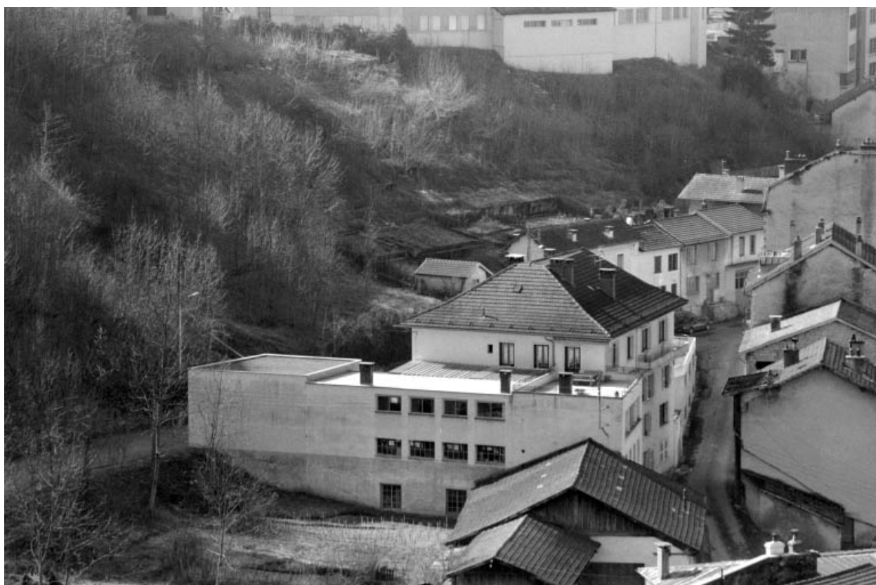
Façades postérieure et latérale droite.
