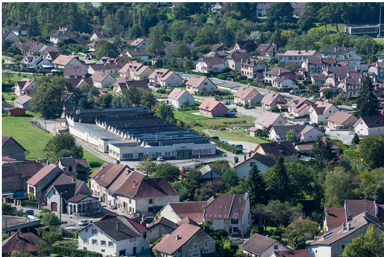
Usine de matériel d'équipement industriel Lipemec, Ornans (13 rue des Contrevaux).
