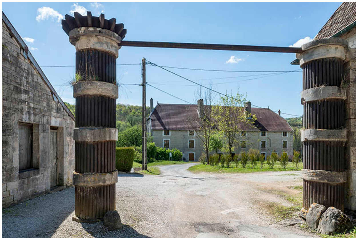
Portique d'entrée. Piliers fasciculés (pierre et fonte).
