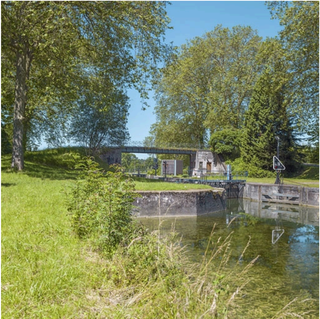
Vue d'ensemble du pont, depuis l'aval.
