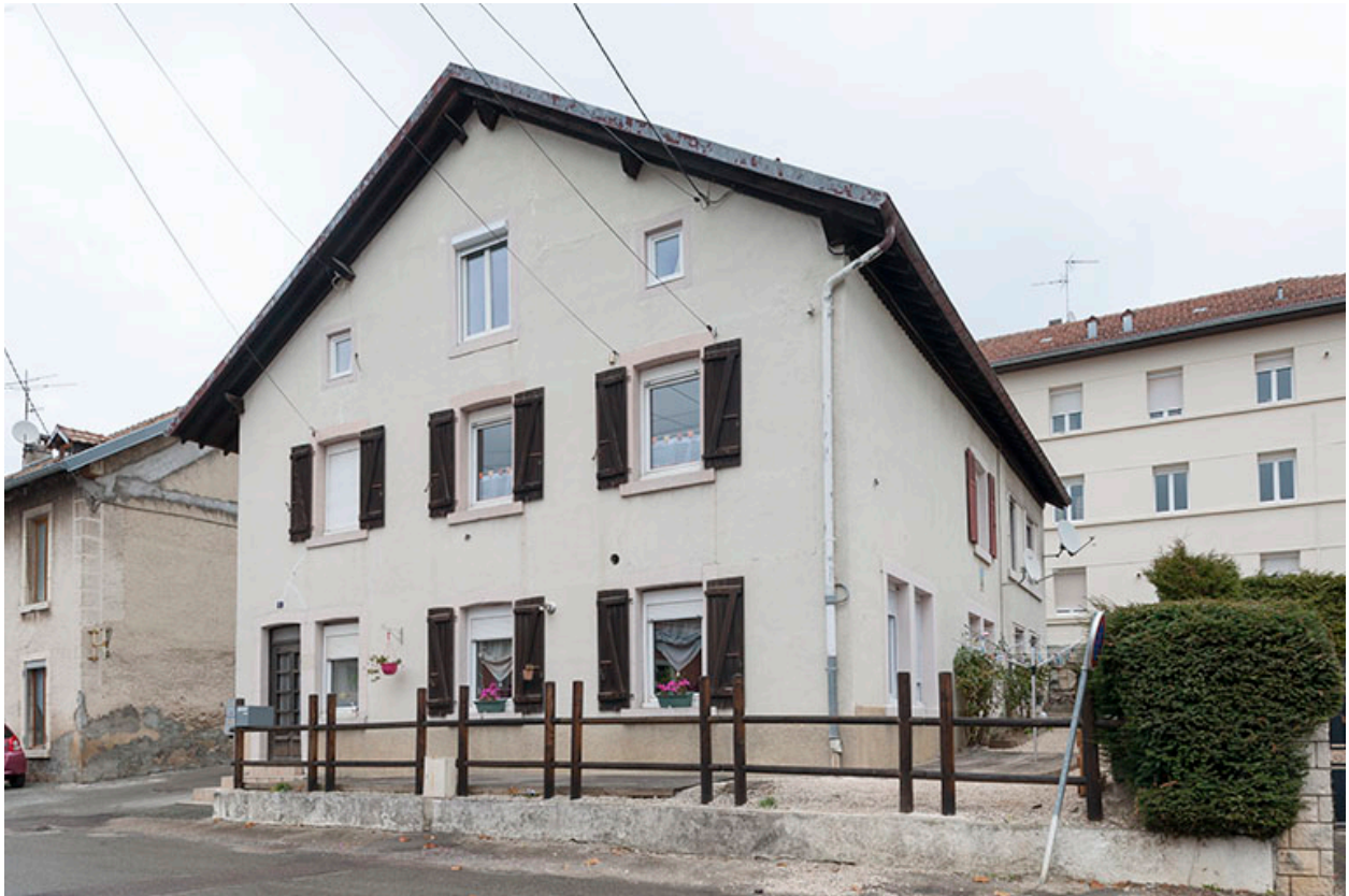
Maison : façades antérieure et latérale droite.
