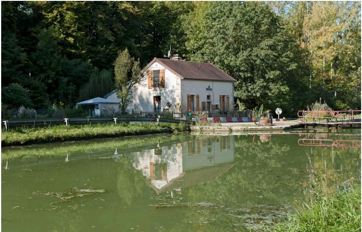
Vue du site d'écluse depuis l'amont.
