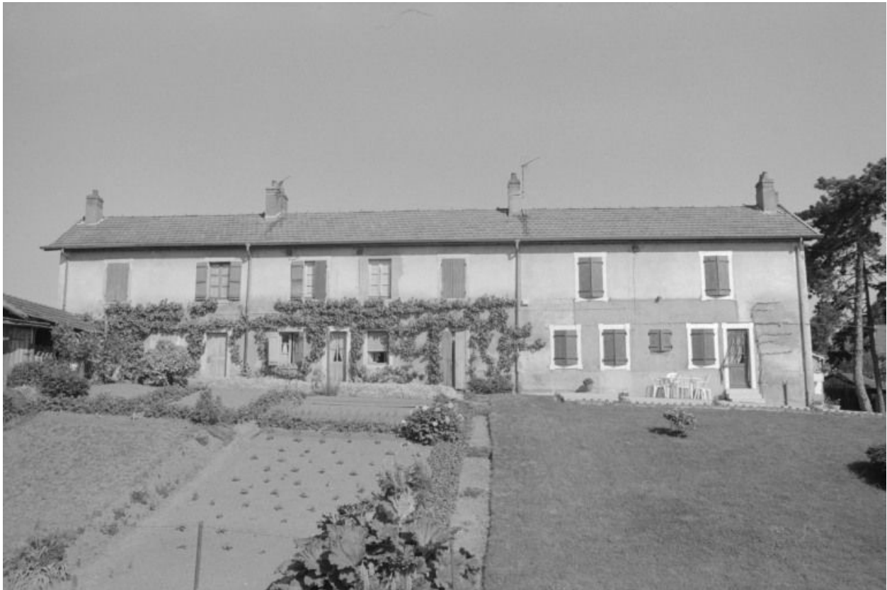
Ferme du Château de Galuzot (anciens logements ouvriers des années 1830 transformés vers 1860 - façade Sud).
