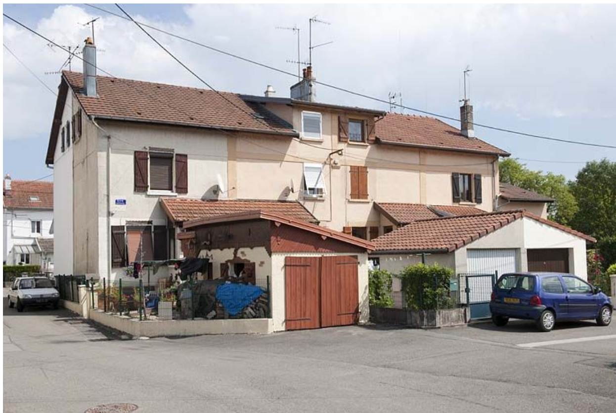
Habitation à 8 logements. Façade ouest.
