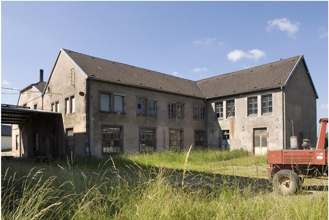
Atelier de fabrication originel. Vue de trois quarts arrière.
