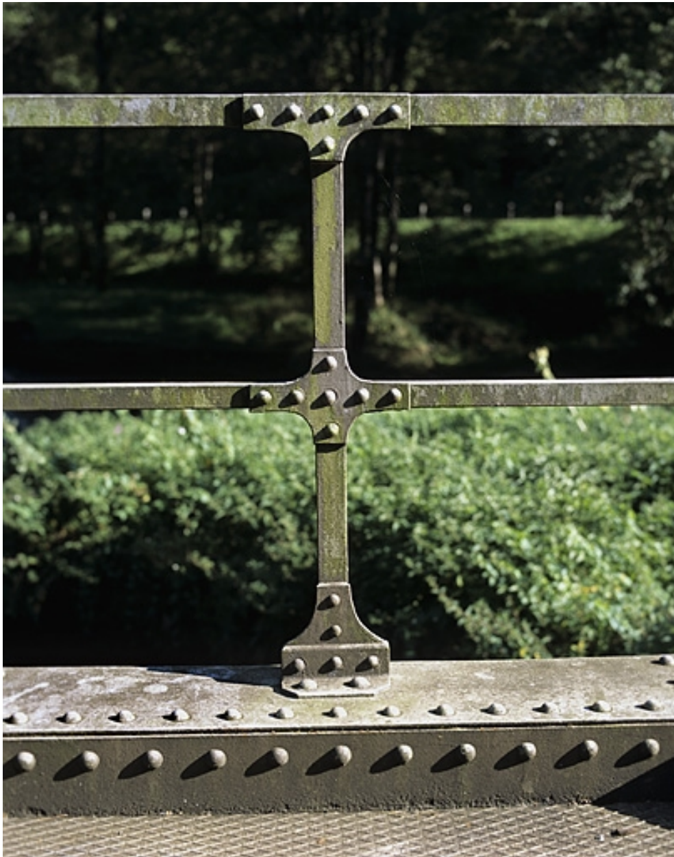
Pont : détail du garde-corps.
