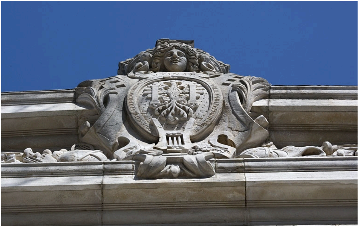
Détail de la partie centrale du fronton avec les armes de la ville, de face.
