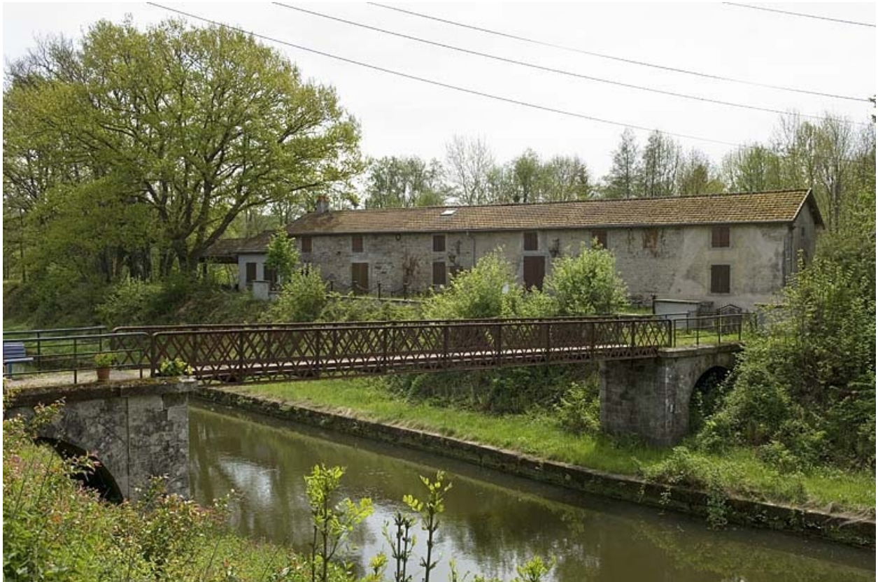
Vue d'ensemble du logement ouvrier collectif (est).
