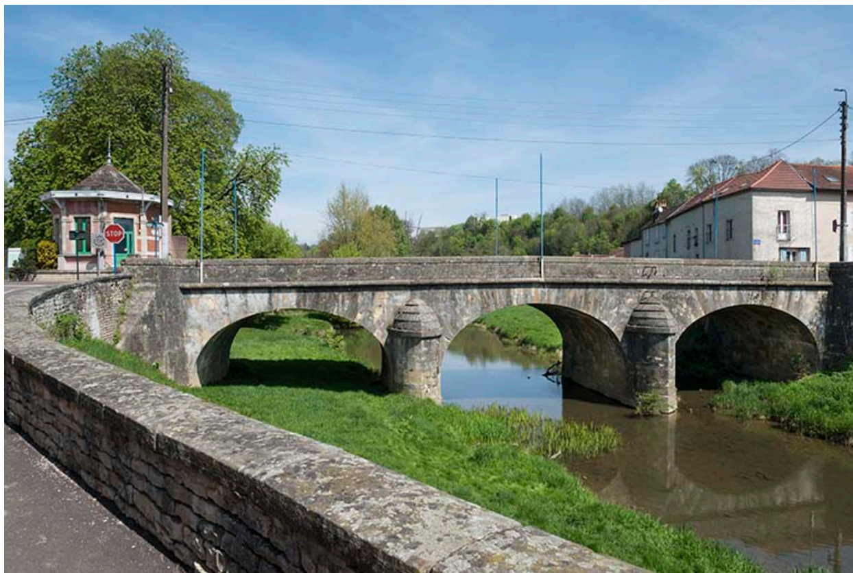
Le pont au niveau de la Rezelle.
